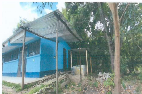
Foto 2: Mejoramiento de muro perimetral e instalación de puerta de metal para ingreso al área de sanitario.
