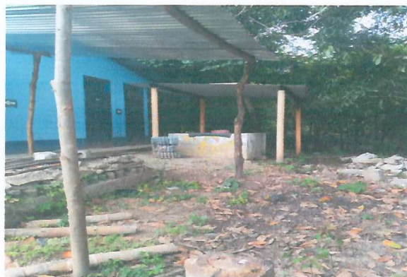
Foto 1: Mejoramiento de muro perimetral e instalación de puerta de metal para ingreso al área de sanitario.
